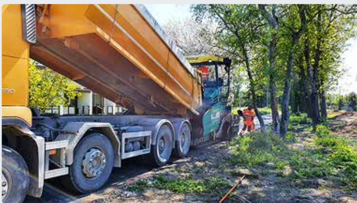
Asfalteerimistööd Viimsi vallas. Foto: Siim Jürima
